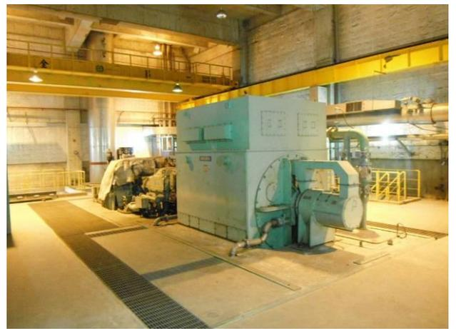
10 渦輪發電機：利用廢熱蒸氣推動渦輪發電機轉換成電能發電。
