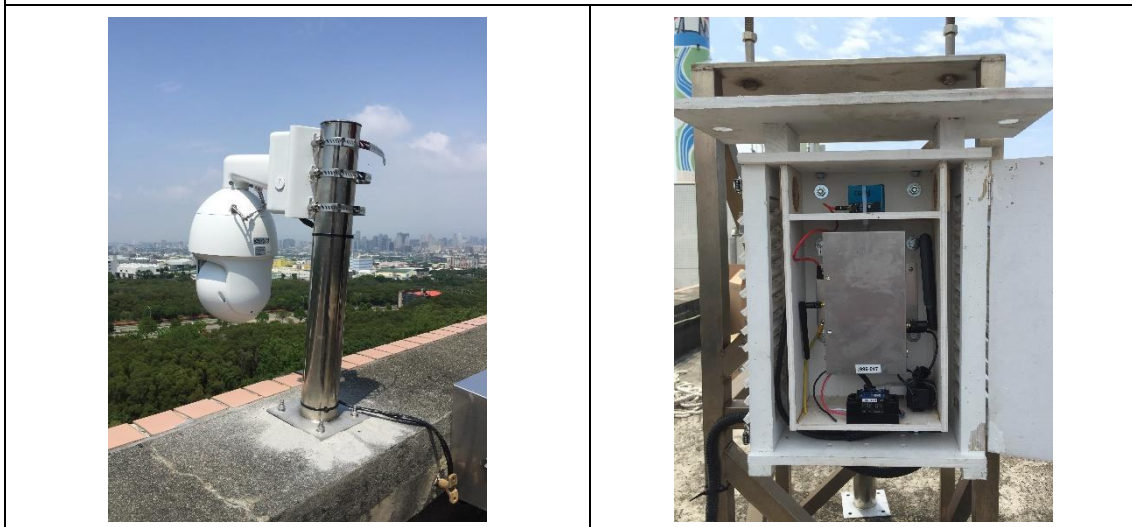
圖 3-8 臺中工業區場域-〇〇焚化廠現場架設
