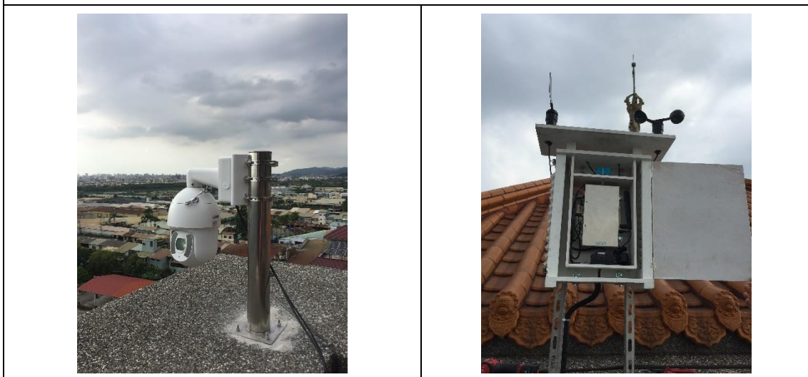
圖 3-10 大里場域-〇〇高級中學現場架設
