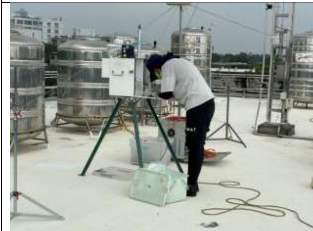
人工監測項目架設情形
