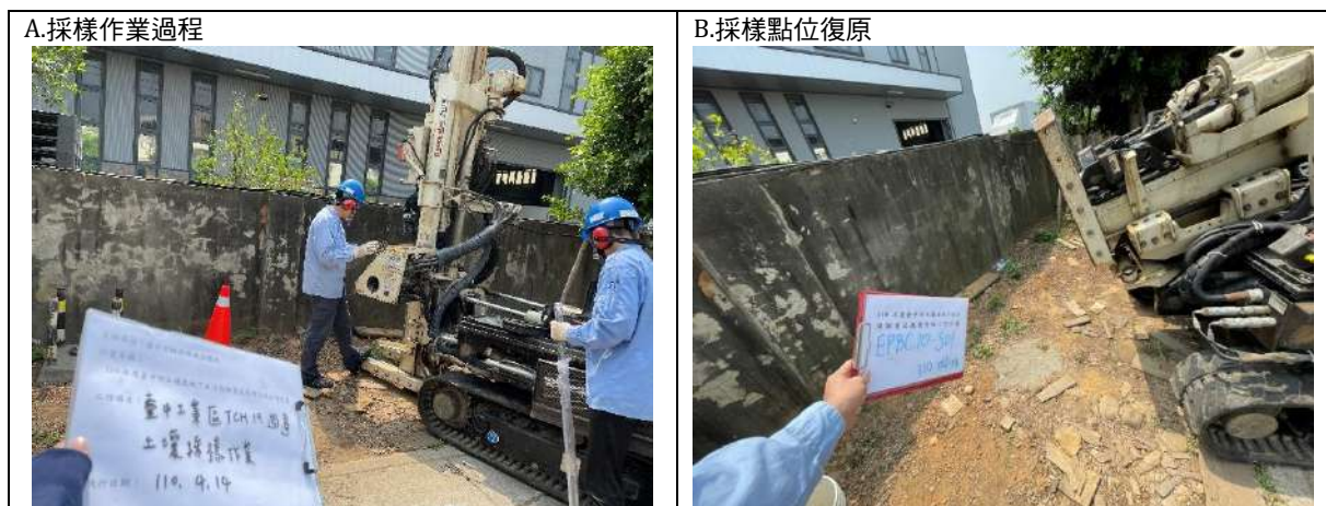
圖 8.4.3-3 B00423 周邊土壤調查現場勘查作業過程
