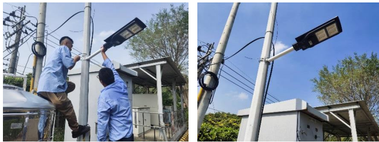
圖 12.7 照明設備設置
