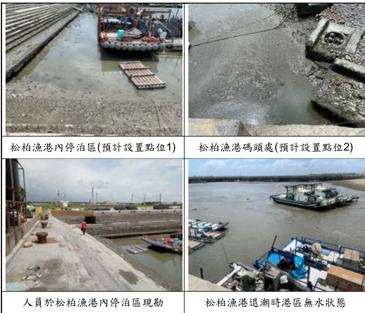
圖 3-3-3 松柏漁港規畫設置點位現勘照片
