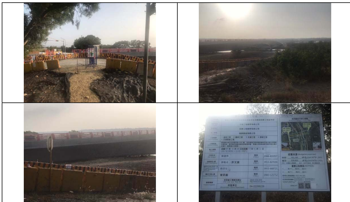
圖 3.4.1-20、新工處工程案現場施工情形。
