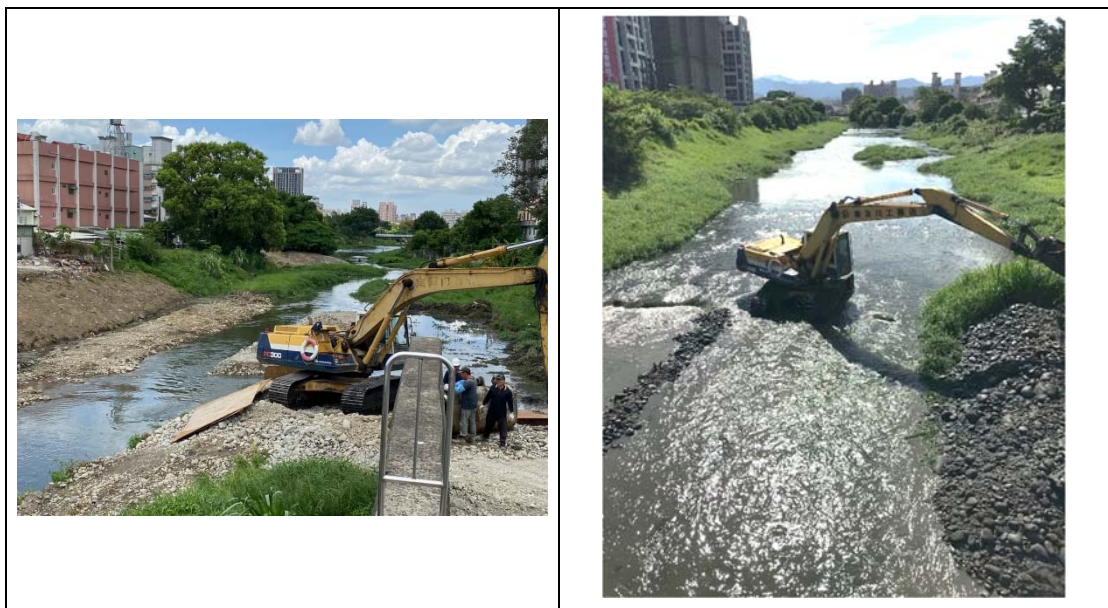
圖 2.4-2、關鍵測站上游河岸施工情形
