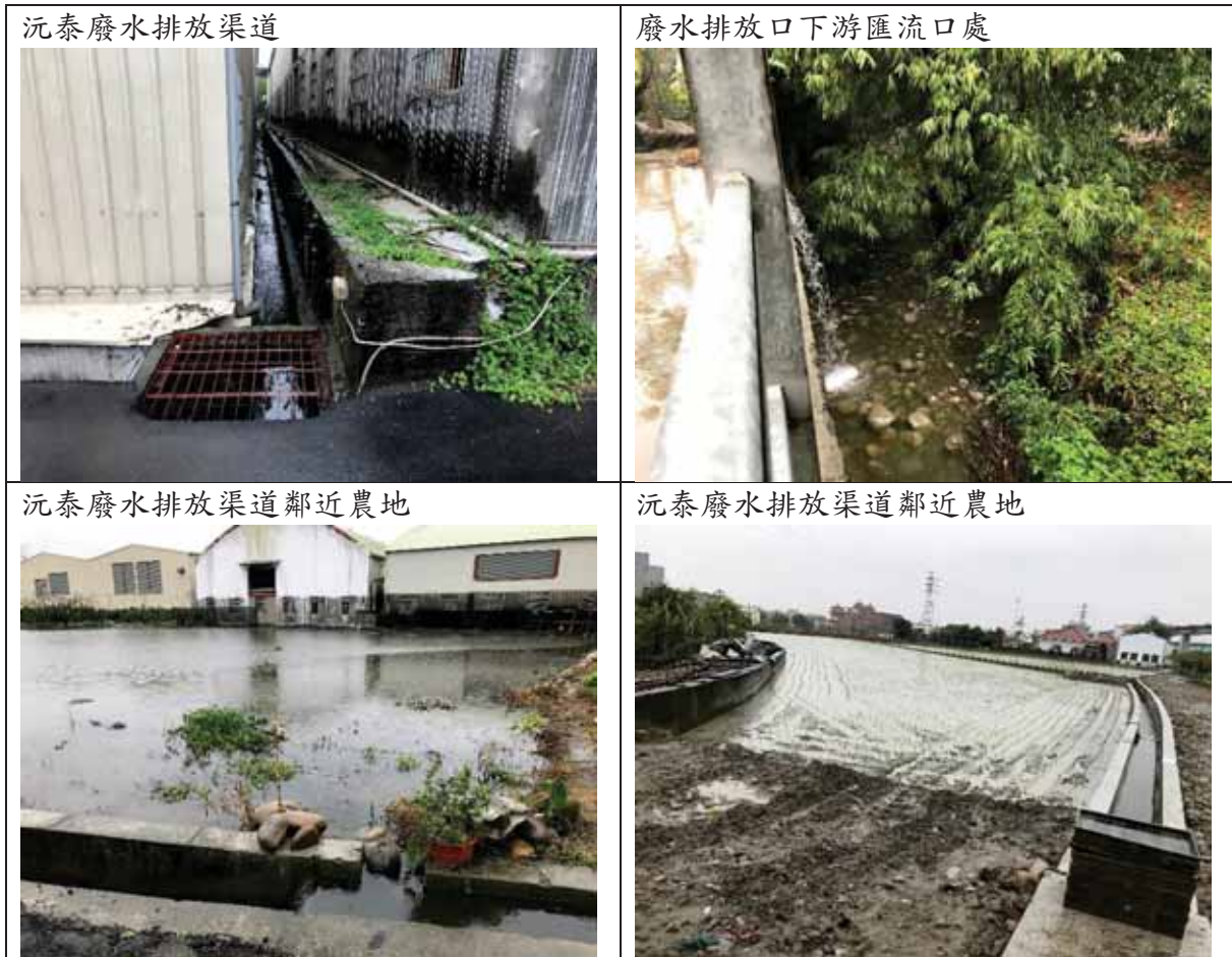
圖 5.2.5-2 神岡區沅泰公司應變調查現場勘查過程紀錄
