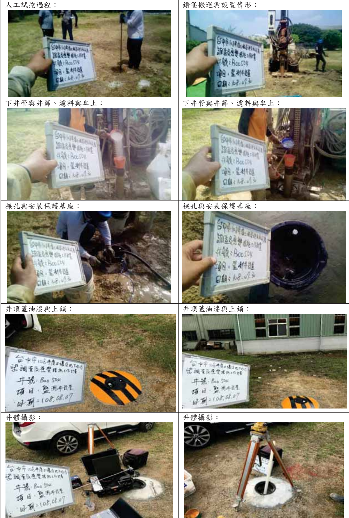
圖 3.4.4-2 大里區金田機械公司 B00504 監測井設置過程紀錄
