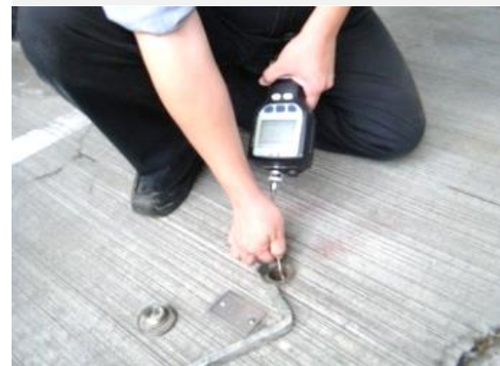
土壤氣體檢測井
