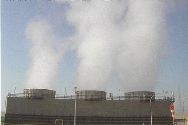
冷卻水塔水汽於天冷清晨時之飛散情形。
