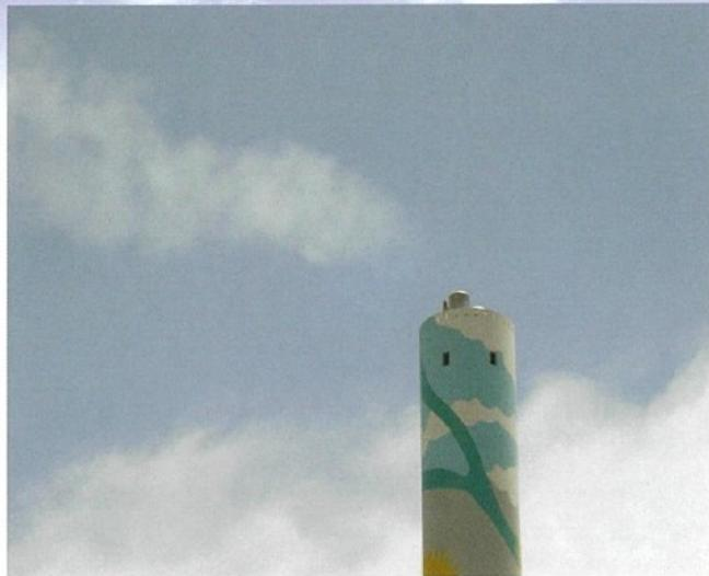
**焚**化廠因採高溫處理一般垃圾，因而有熱氣產生，其經過無害處理後會經由煙囗排出，由於熱氣溫度達140-160°C，若遇冷空氣時即會凝結為水蒸氣，因此在冬令時節或清晨較冷時即會看到白色水蒸氣由煙囗排出；就如同冬天呼氣時或汽車排氣管有白色煙霧出現一般。
