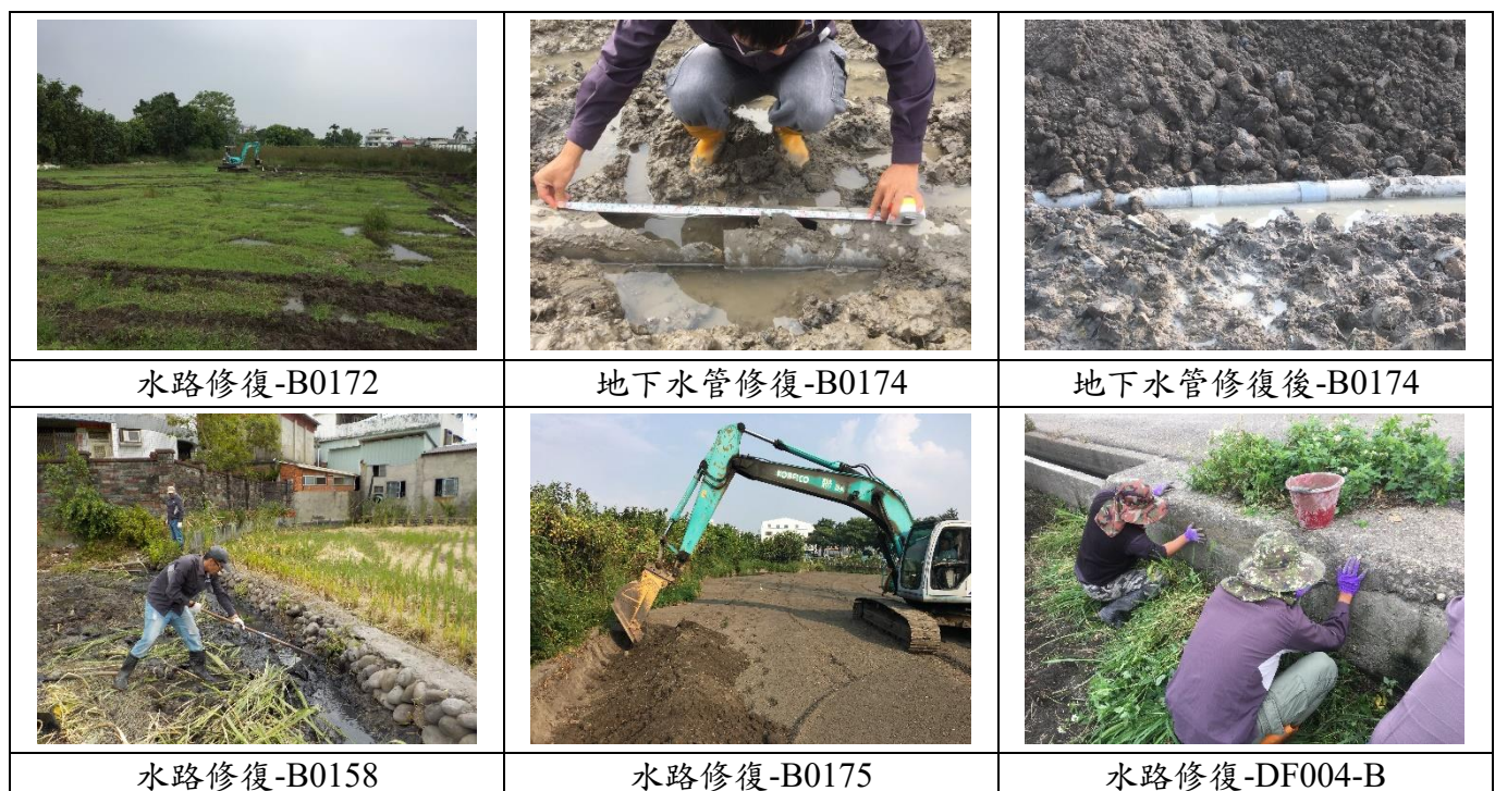
圖 4.7-3 水路修復照片
