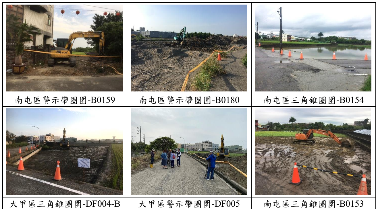
圖 4.7-2 臨路改善坵塊安全警示設置照片
