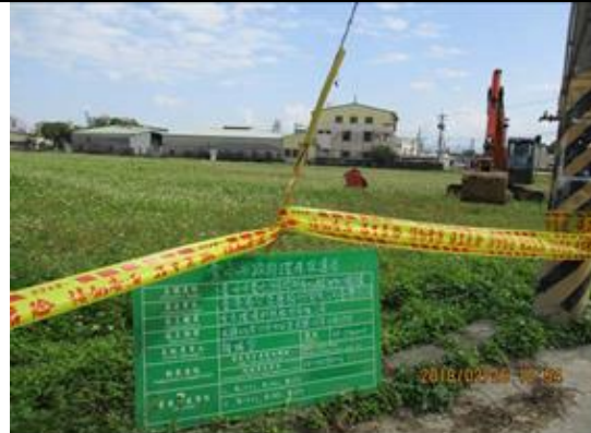
施工告示牌、警示帶設置
