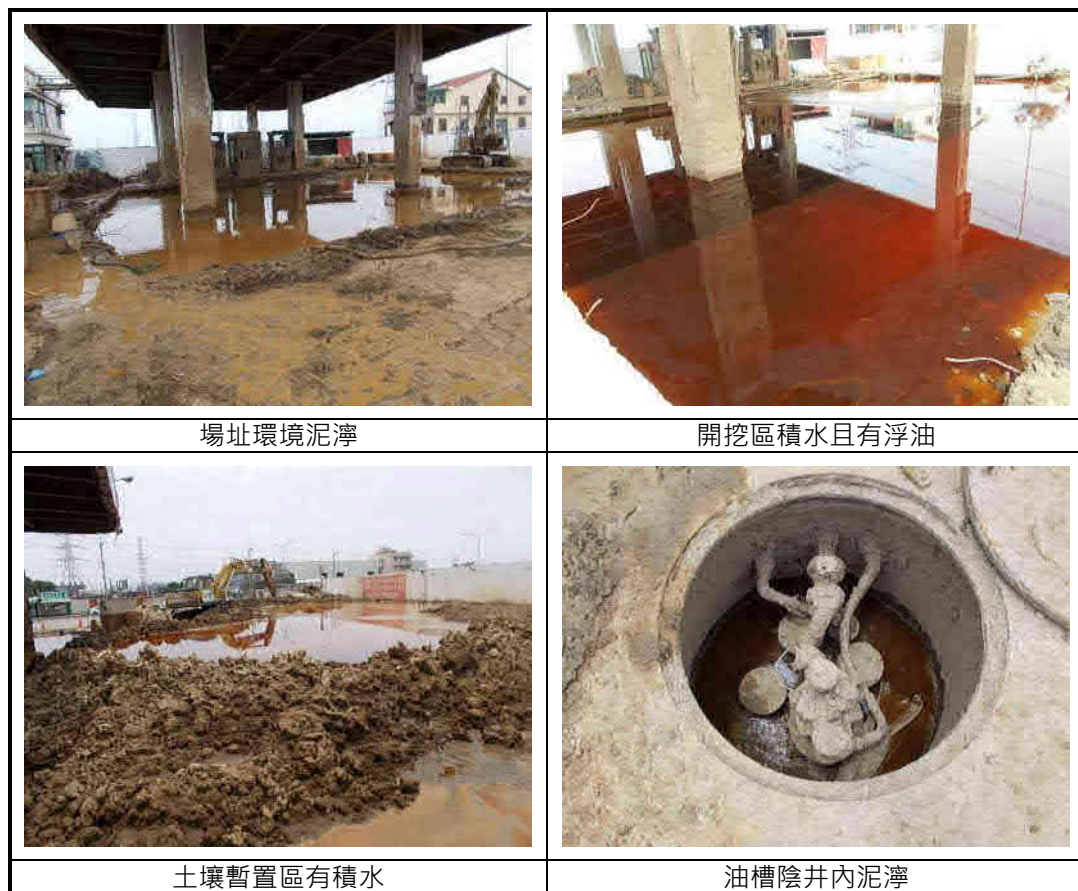
圖 4.6.2.2-16 山隆龍井加油站現場照片
