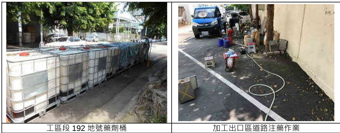
圖 4.6.2.2-7 潭子出口區場址巡查照片(2/2)
