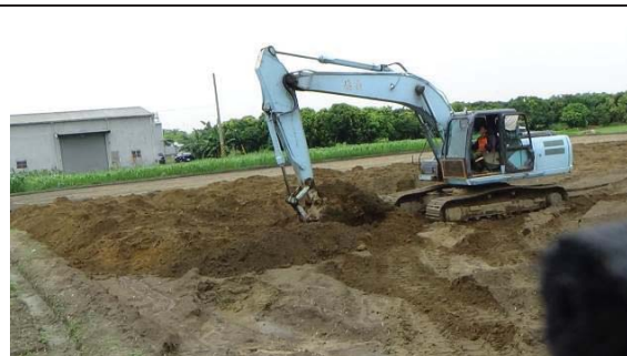
105.8.29-坵塊代號 W011 挖土機犁耕
