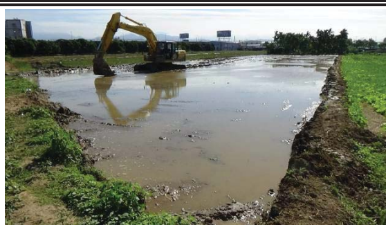
105.12.27-坵塊代號 W023 整平淹放水坵塊
