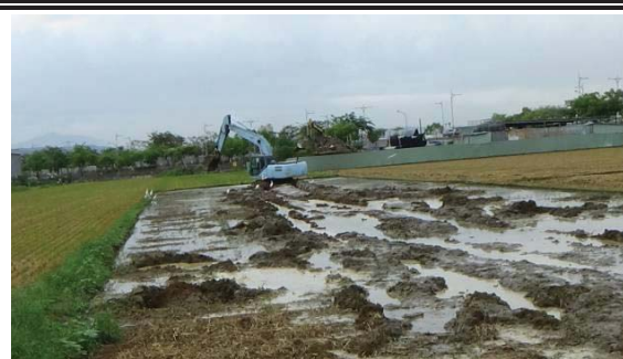
105.11.21-坵塊代號 W028 挖土機施作地力回復(挖掘水路)
