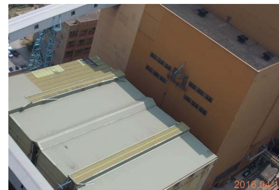
防制設備：靜電集塵器(A102)
