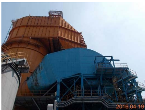
防制設備：排煙 脫硫系統(A103)
