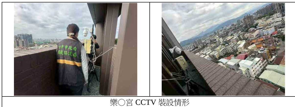
圖 3.5-4 微型空氣品質感測器及 CCTV 影像判煙系統裝設情形
