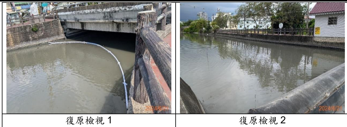
圖 3-1-12 烏日區太明路污染事件處理情形
