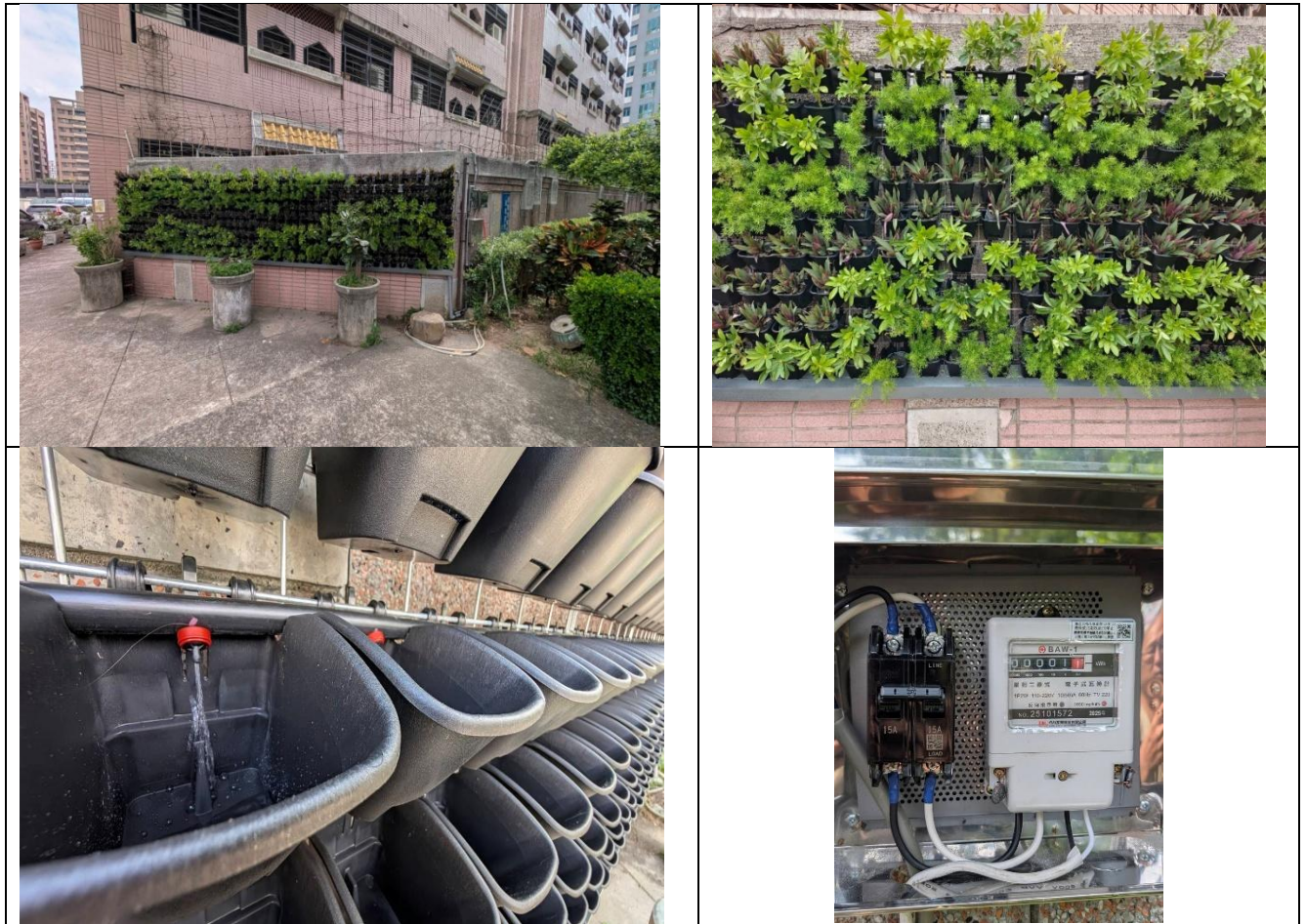
圖 5.2-10 完成綠牆系統建置
