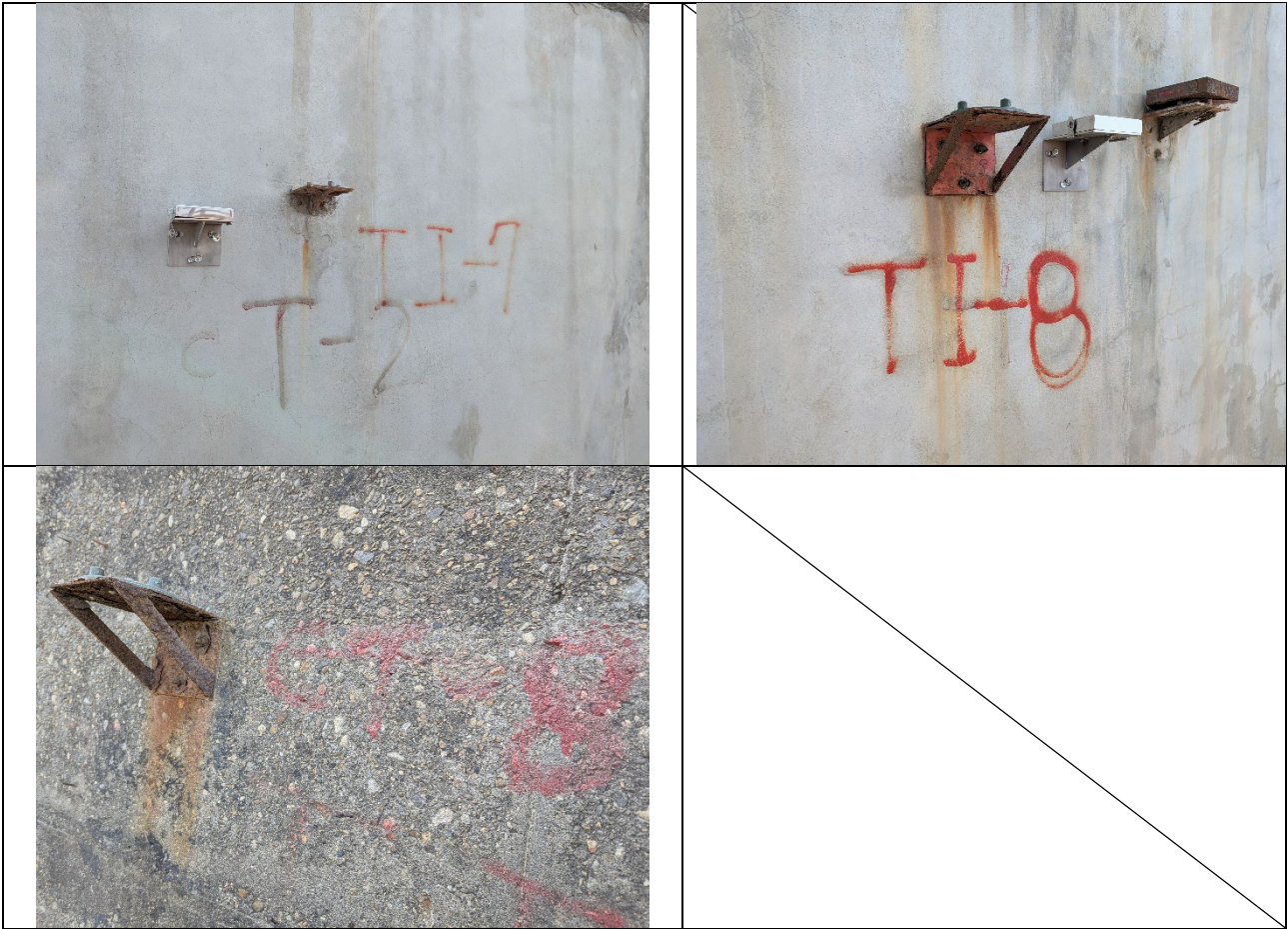
圖 3.3-1 安裝新傾度盤
