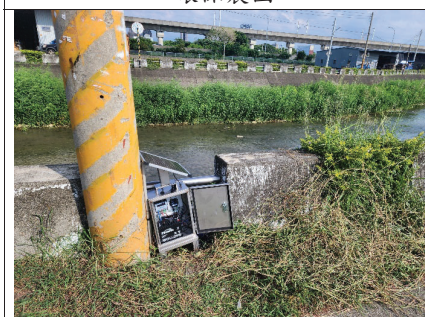
架設水質監測設備
