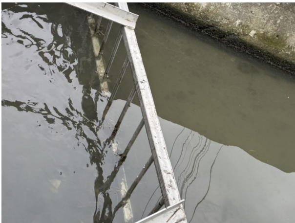
圖 1、攔除閘門設置情形
