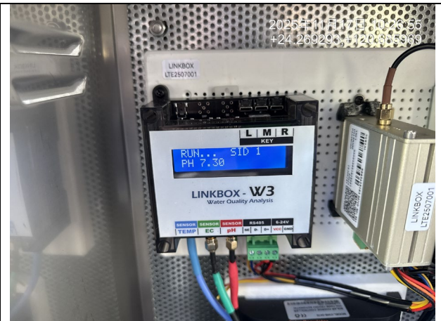
設備安裝情形 2
