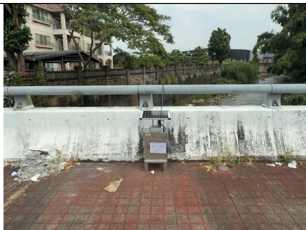
設備安裝情形 1
