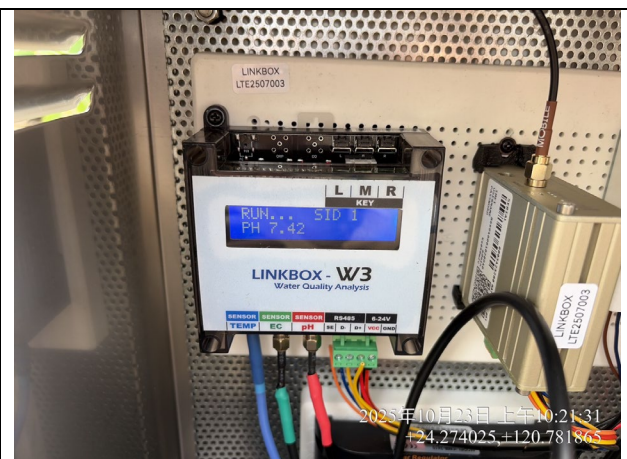
設備安裝情形 2
