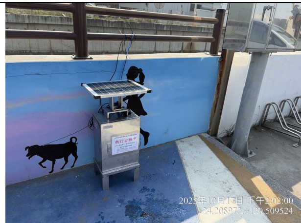
設備安裝情形 1
