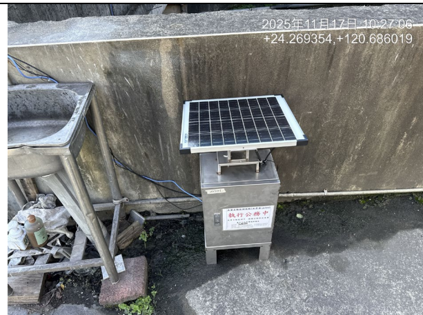
設備安裝情形 1
