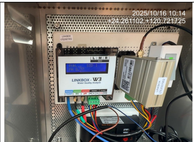
設備安裝情形 2
