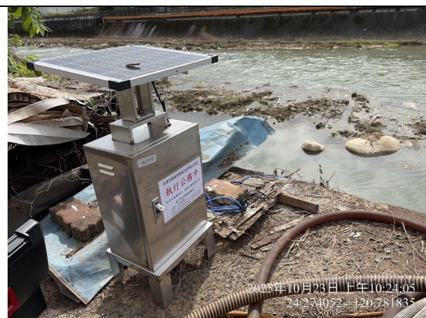
設備安裝情形 1
