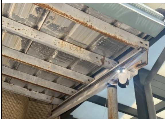
138. 北屯區監視器照明燈光害
