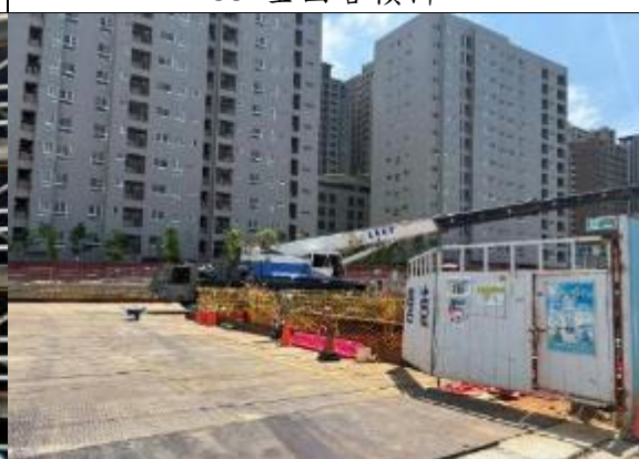
35. 國安社會住宅二、三期建案工地
