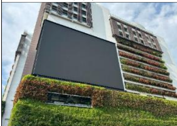
76. 西區勤美綠園道廣告牆光害
