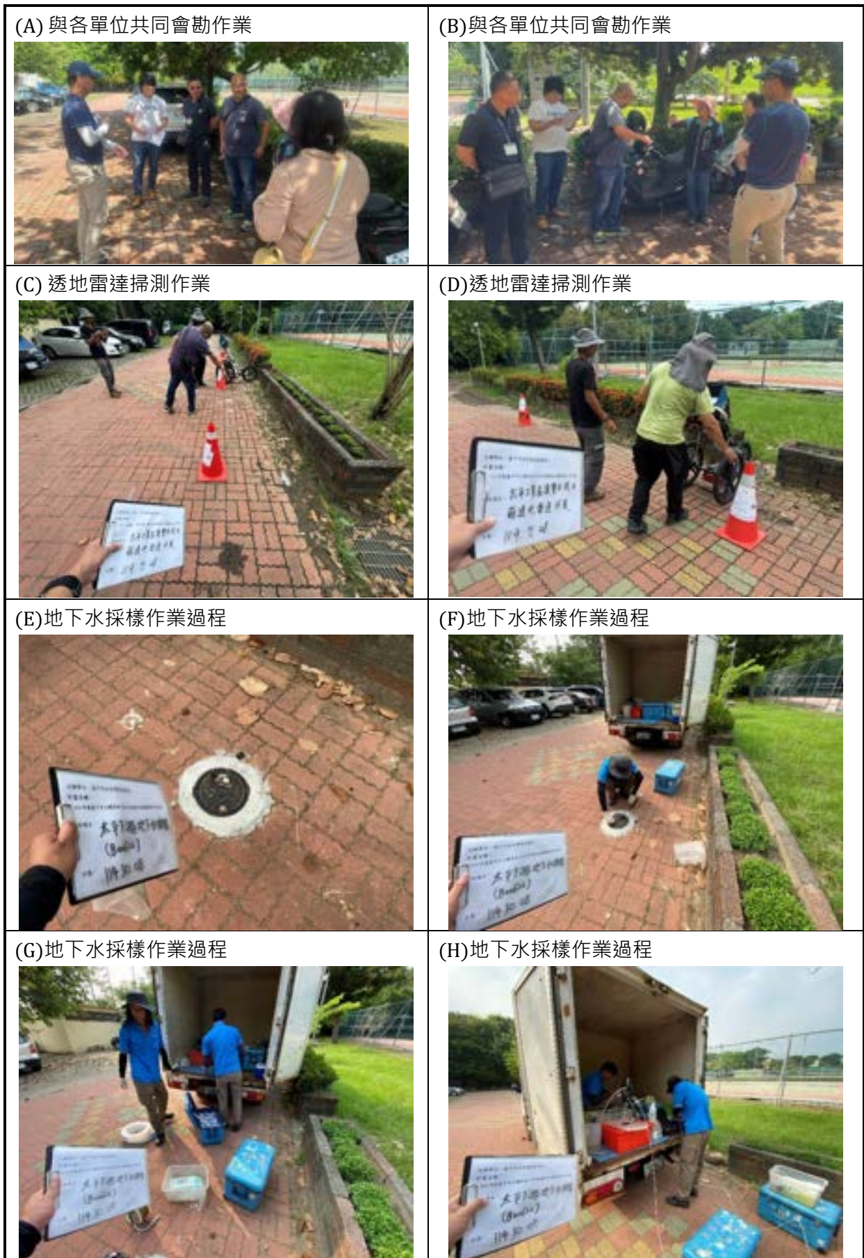
圖 4.3.3-2 太平工業區 B00622 監測井設置前地下管線確認及地下水採樣過程
