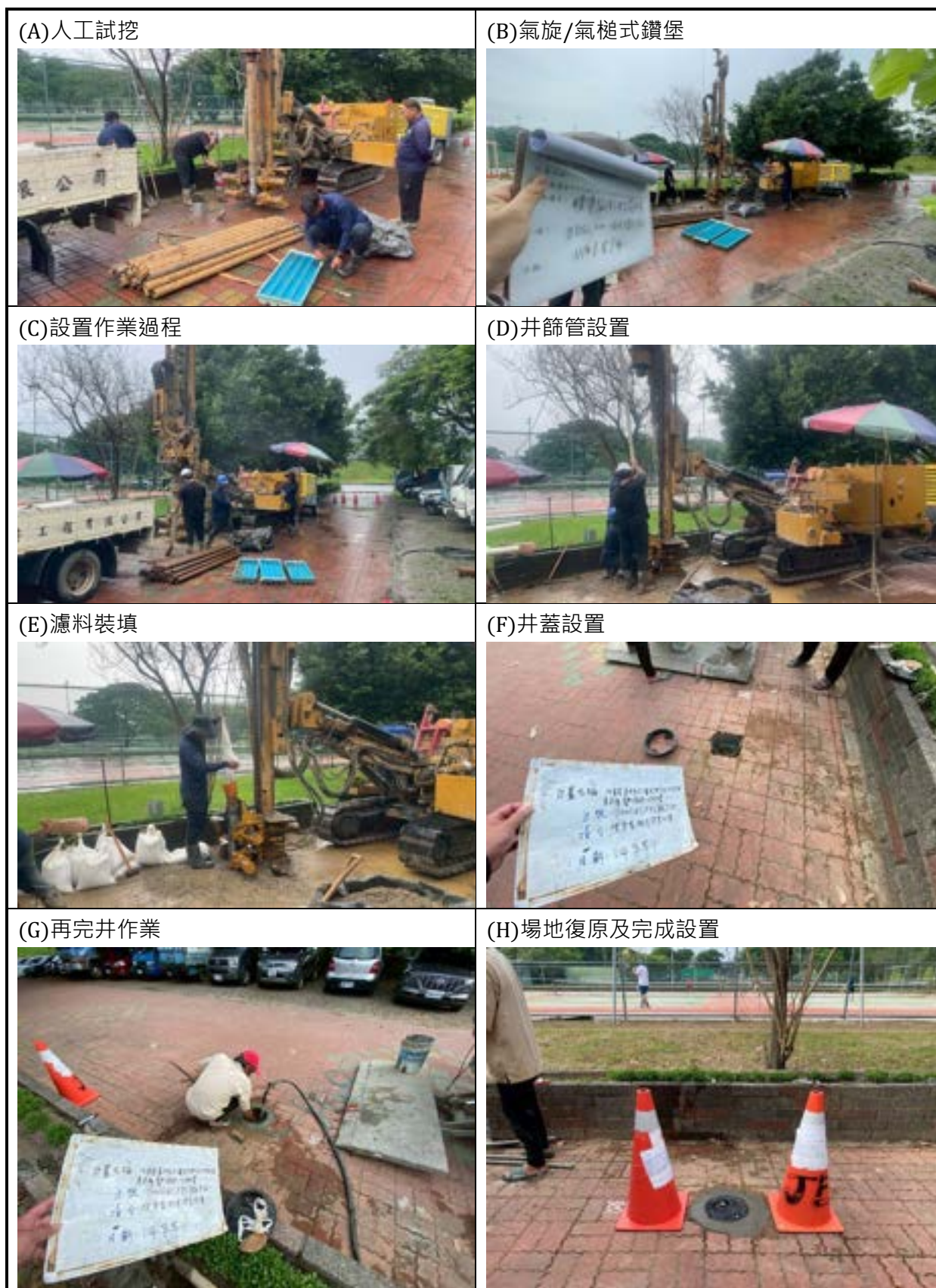
圖 4.3.3-1 太平工業區 B00622 監測井設置過程紀錄
