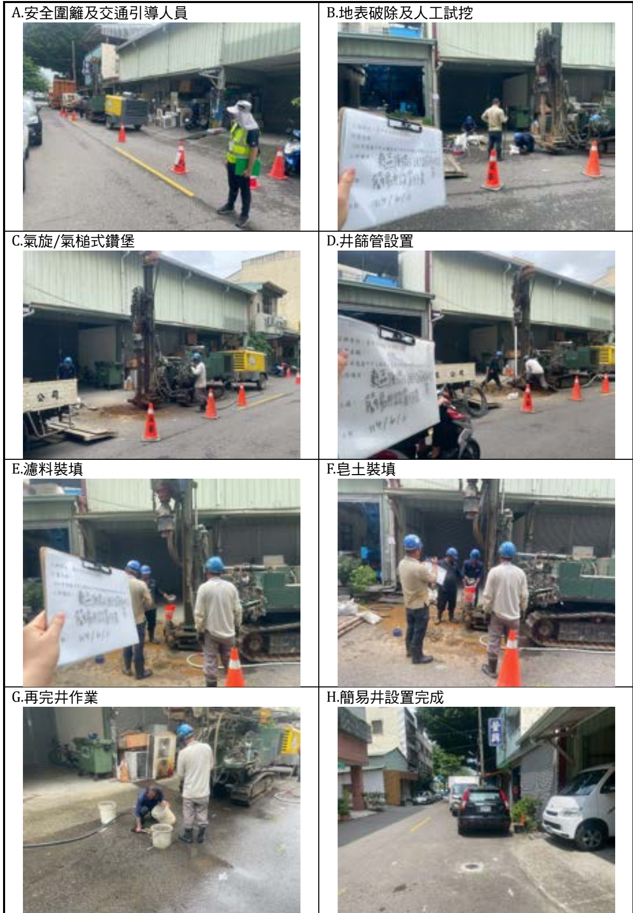
圖 5.2.1-4 地下水 B00621 簡易井設置作業過程紀錄
