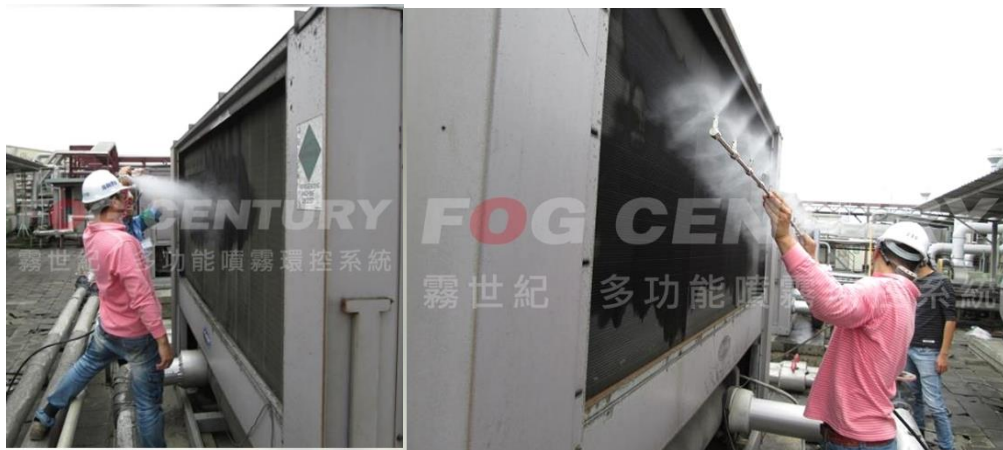
圖 3.3.3.6 氣冷式冷凍機冷卻鰭片安裝噴霧降溫系統示意圖
