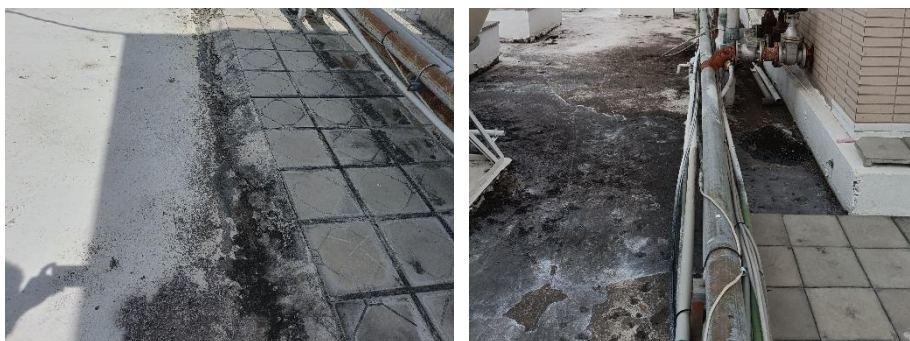
圖 3.3.3.4 第一次現勘頂樓狀況
