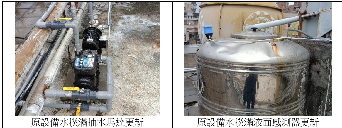
圖 3.3.3.16 水撲滿抽水馬達設備更新施作
