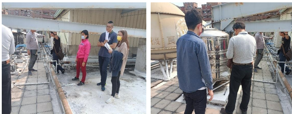
圖 3.3.3.11 自動化水霧噴降溫系統施工建置前現場勘查照片
