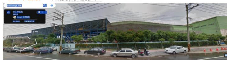
106年街景 新鋼筋廠建廠中(105~107年)
