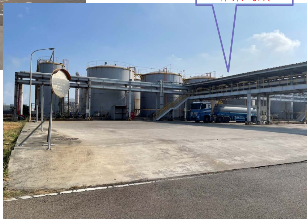
裝卸管線管架 作業碼頭
