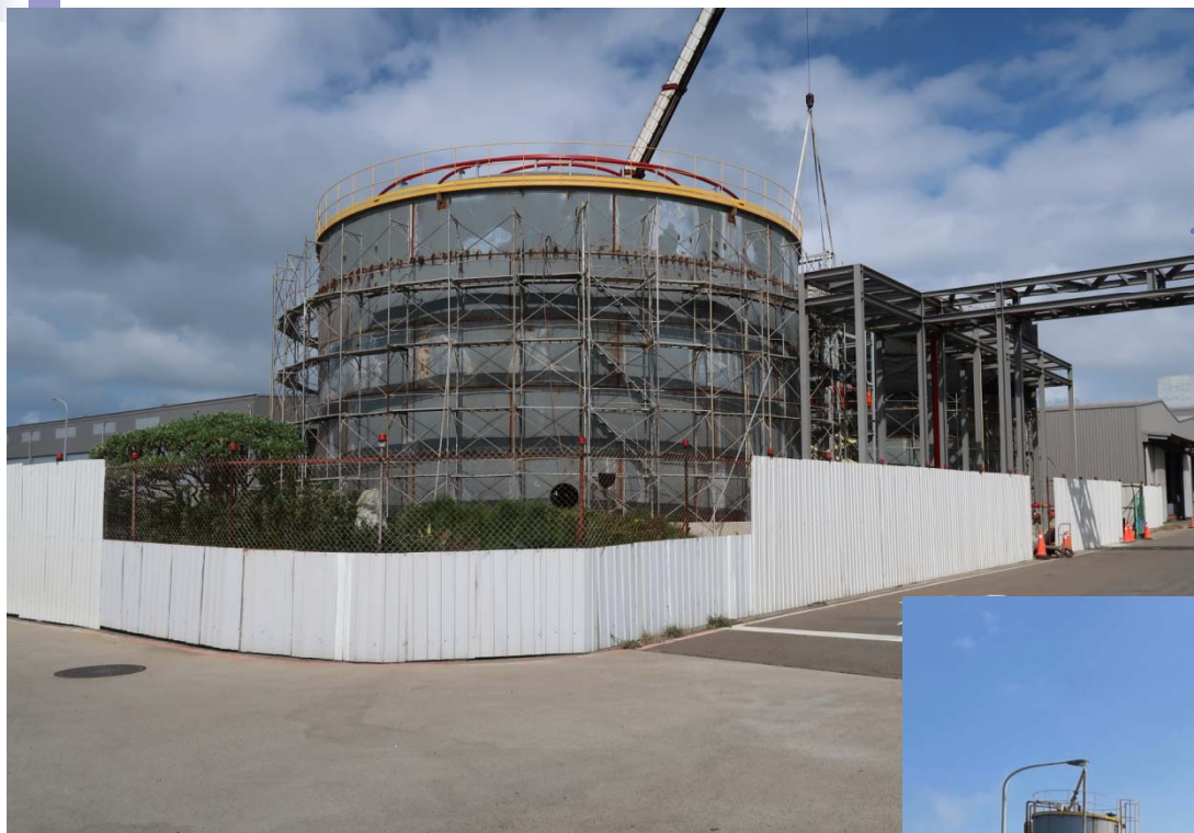
廠區儲槽興建 作業情形
