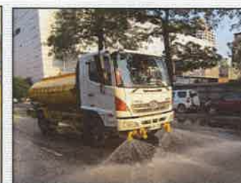
工區外道路洗掃
