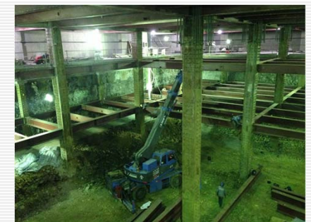
土方開挖及 地上結構體施工
