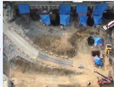
開挖抽水及降水
