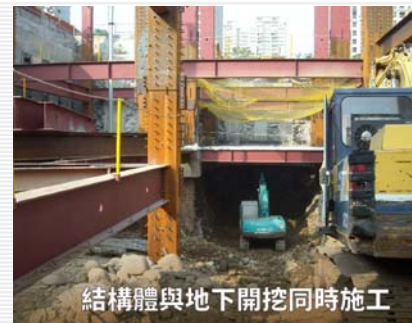
土方開挖及 地上結構體施工
