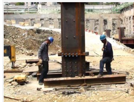
吊放逆打鋼柱
