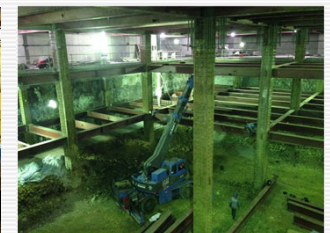
結構體與地下開挖
