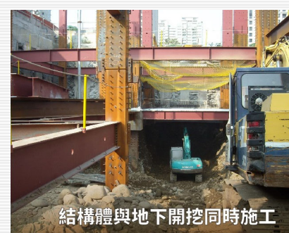
土方開挖及 地上結構體施工
