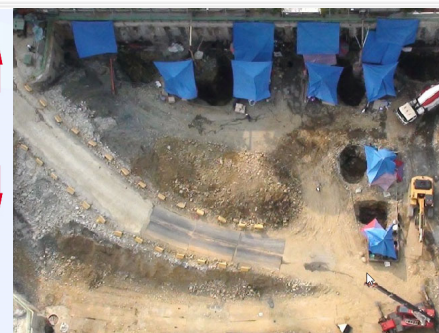
開挖抽水及降水
