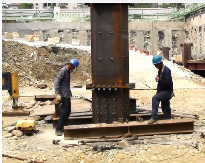
吊放逆打鋼柱
