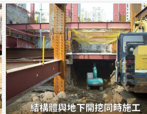
結構體與地下開挖
