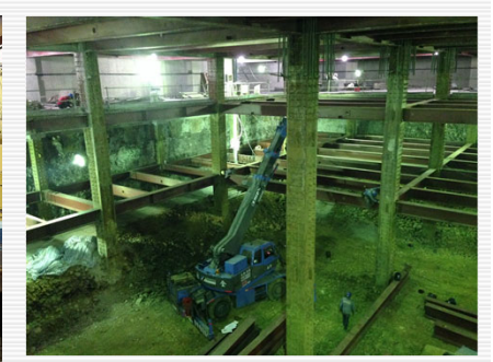
土方開挖及 地上結構體施工
