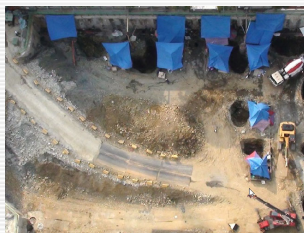
開挖抽水及降水
