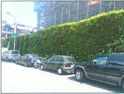
施工圍籬綠美化
