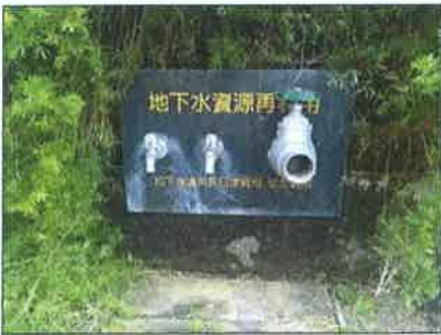
設置地下水貯存水箱及水龍頭
