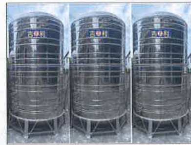
地下水貯存臨時水塔
