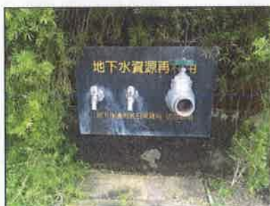
設置地下水貯存水箱及水龍頭
