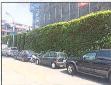
施工圍籬綠美化
