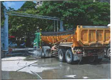
離場運輸車輛輪胎清洗及覆蓋防塵網
