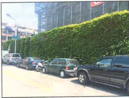
施工圍籬綠美化
