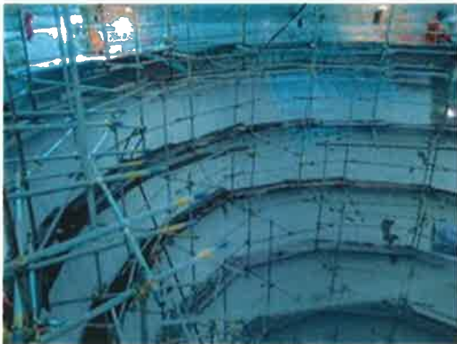
圖 1. 成品儲槽內部搭架檢查修理焊道龜裂情形
