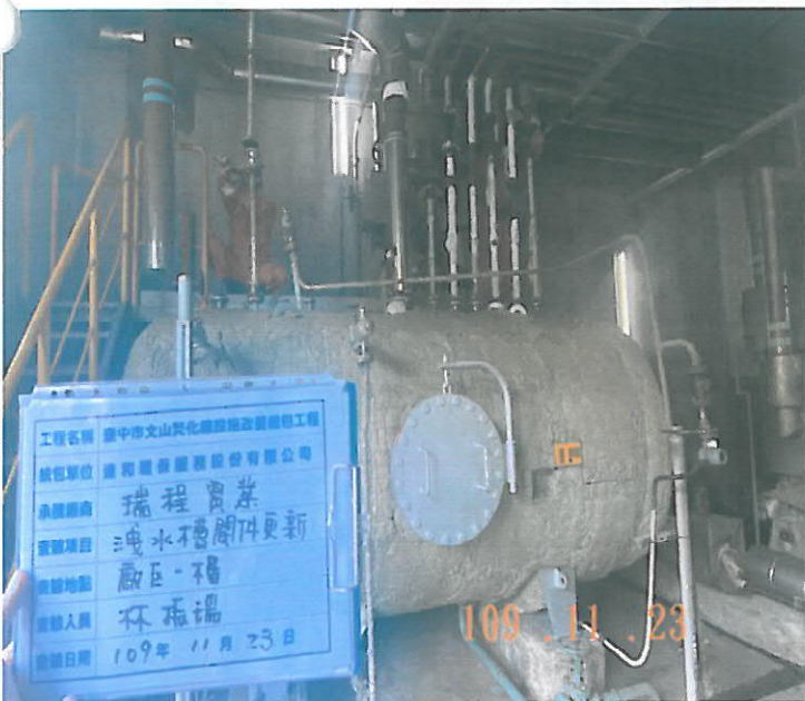
舊有閥件拆卸
