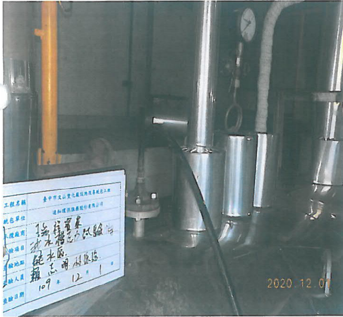
拆卸安全閥連接水壓機補水
