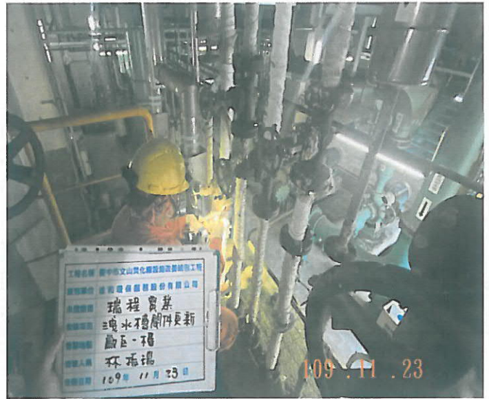
舊有閥件拆卸
