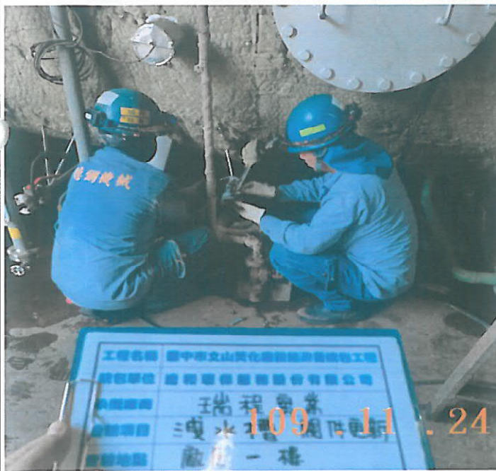
閥件安裝作業
