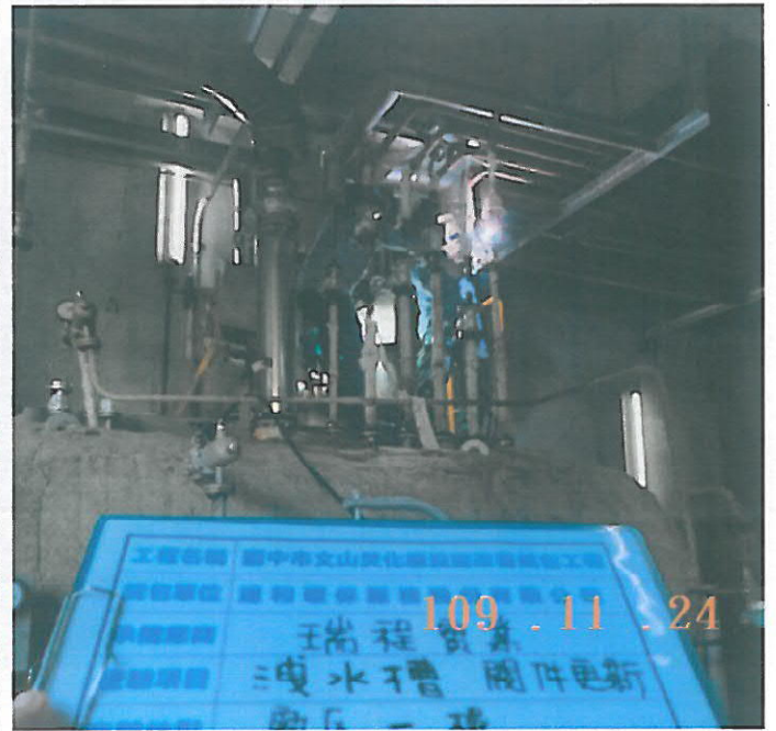
閥件連接管路焊接施工
