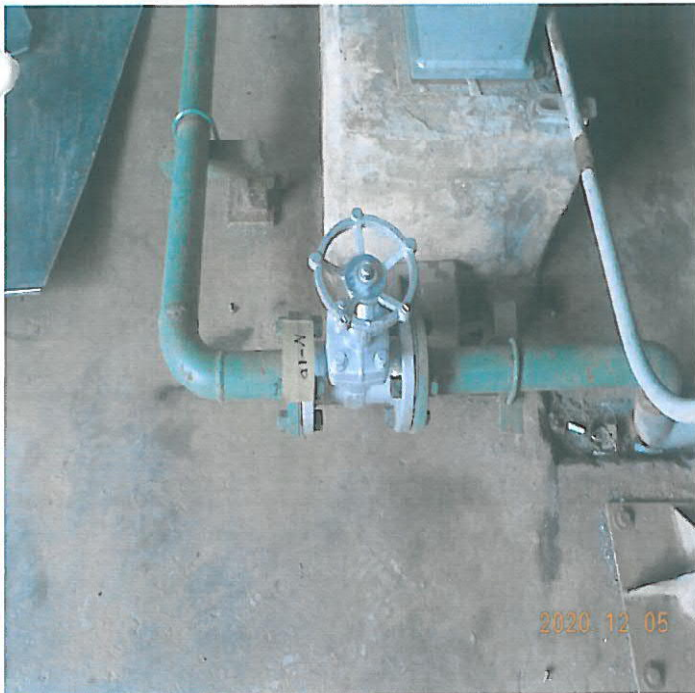
底排放閥更新
