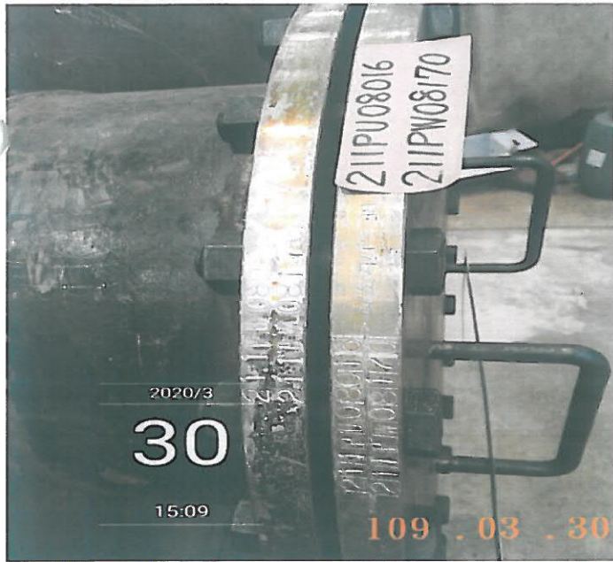
槽體鋼印編號確認
