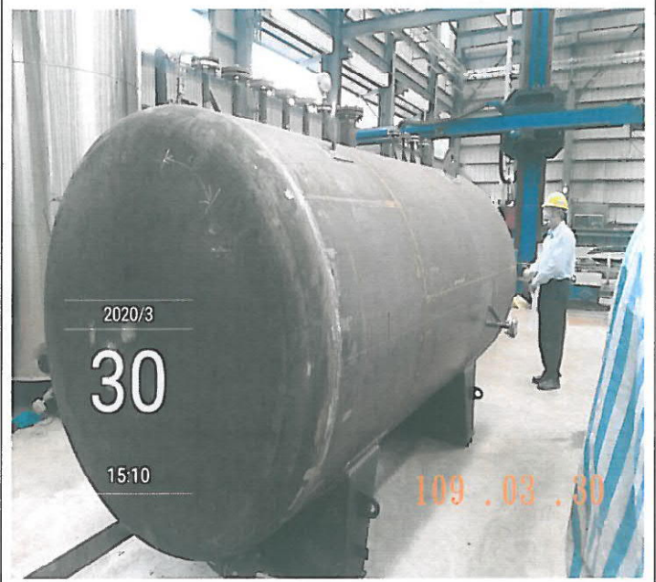
槽體外觀檢查
