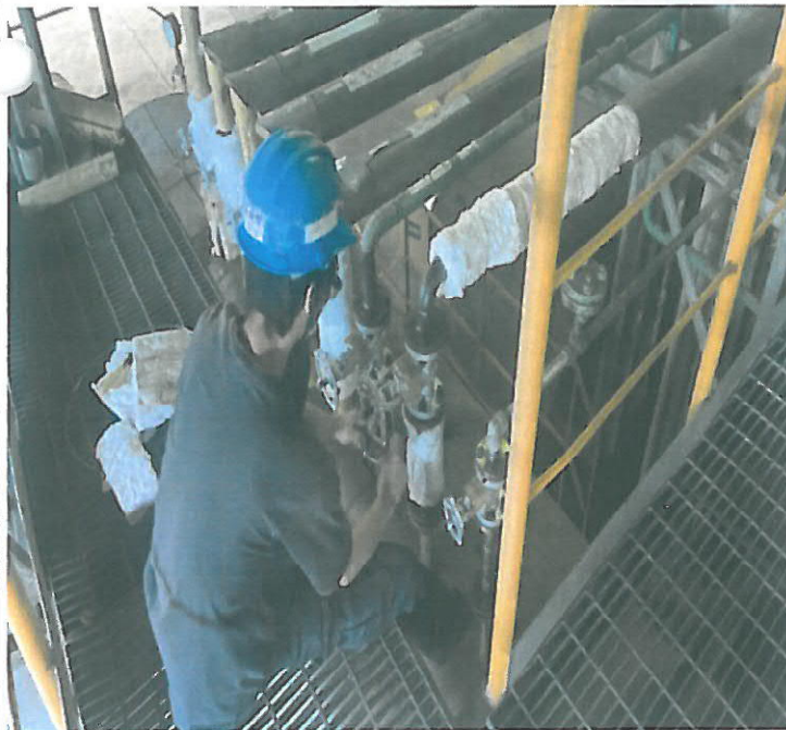
手閥管路保溫包覆施工
