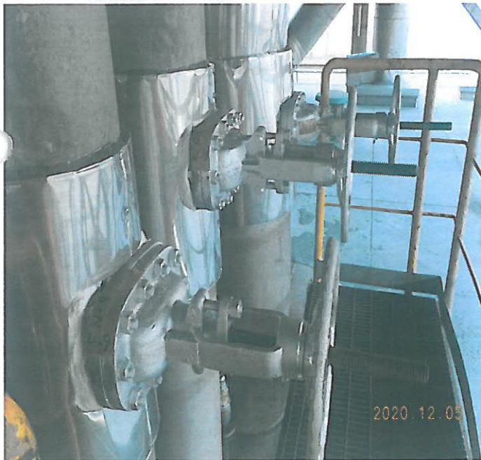
入口連接閥更新完成
