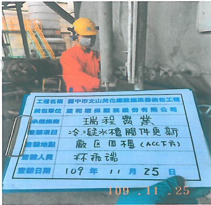
舊有閥件拆卸
