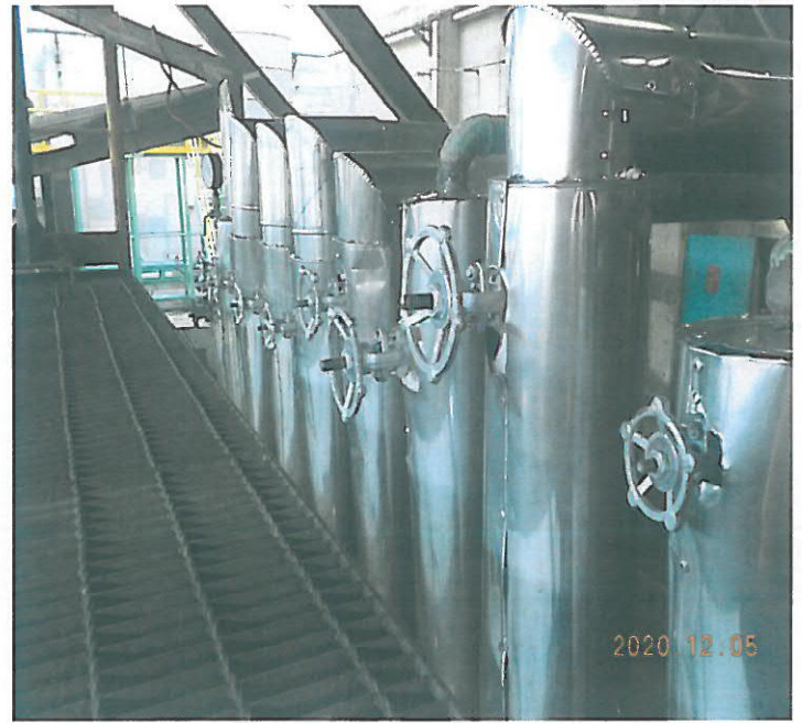
入口連接閥更新完成
