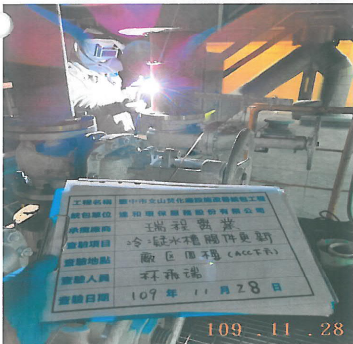
手閥管路更新施工
