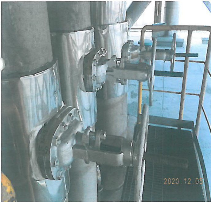
入口連接閥更新完成
