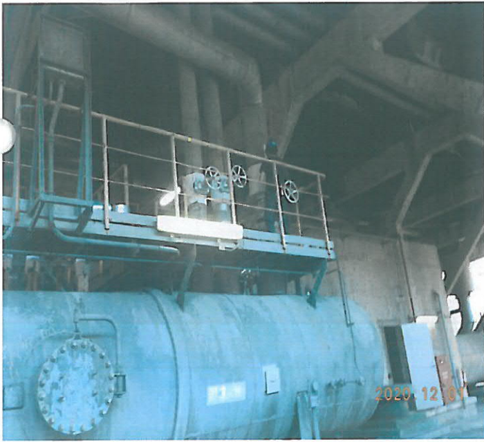
手閥保溫包覆施工
