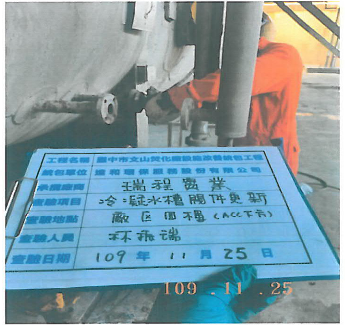
舊有液位計拆卸
