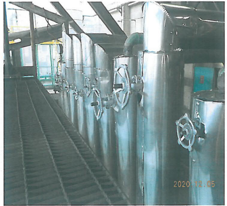
入口連接閥更新完成
